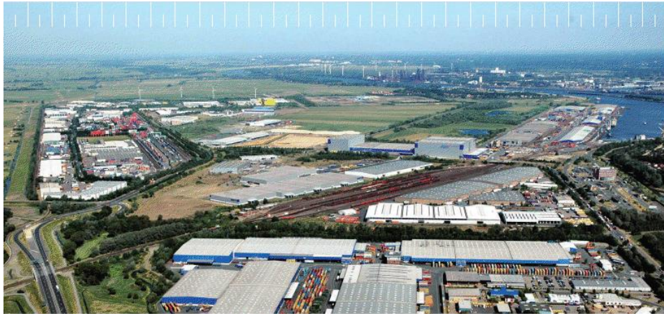
Hình 1.6 Trung tâm logistics cảng biển GVZ Bremen
