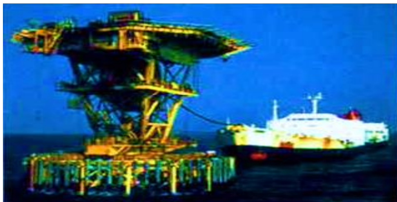
Hình 1.12. Dạng liên kết dây mềm với chân đế Jacket
