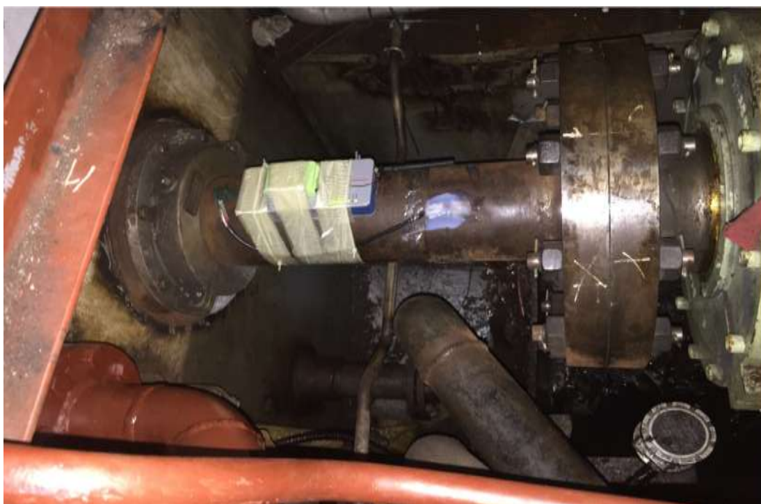
Hình PL3-7 Lắp đặt thiết bị đo MMX trên trục trung gian
