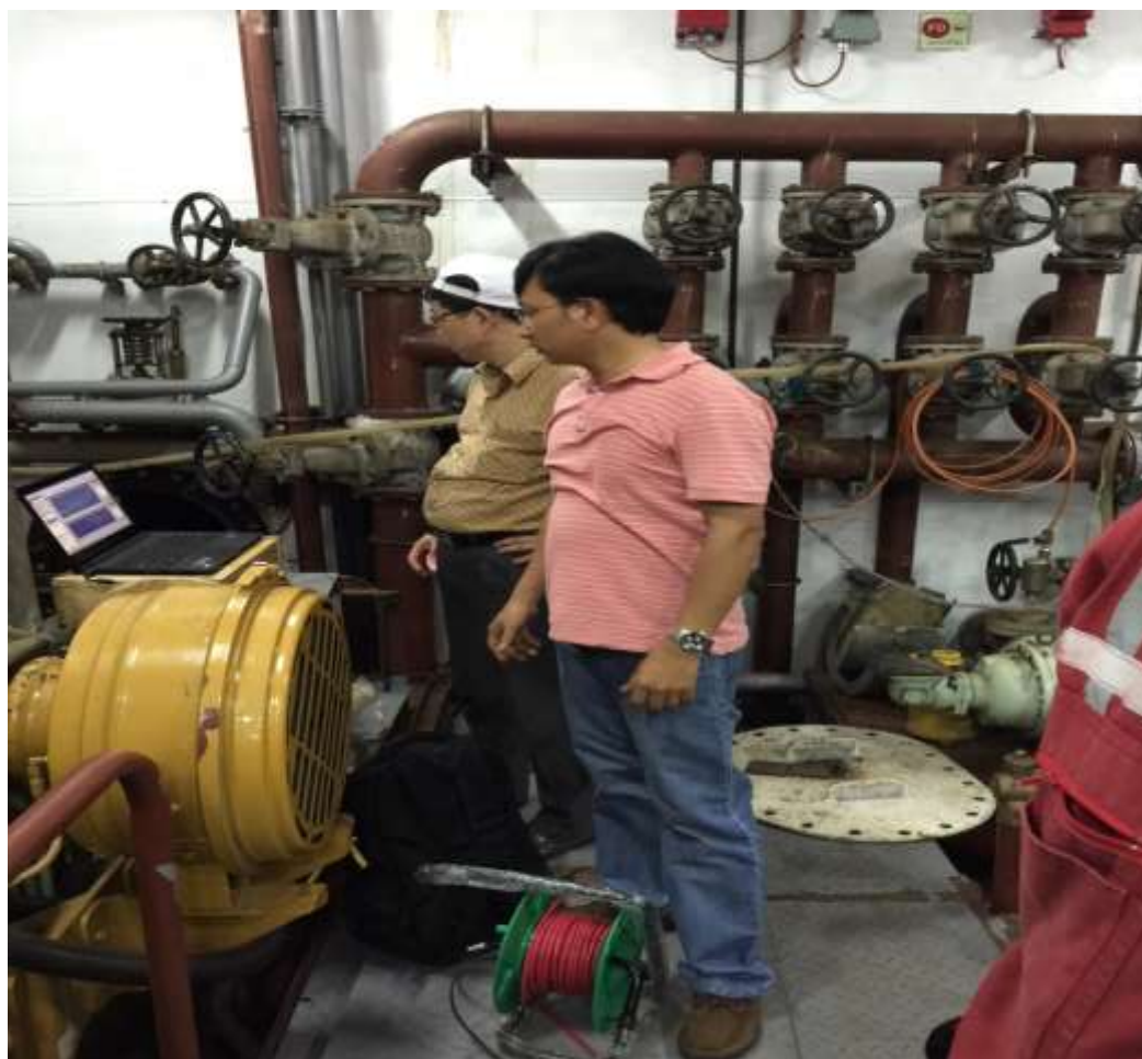
Hình PL3-9 Ghi lưu dữ liệu tín hiệu MMX trên trực trung gian
